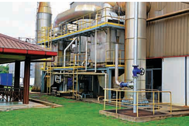
Peralatan seperti economiser dipasang untuk memulih tenaga di kilang-kilang kami.
